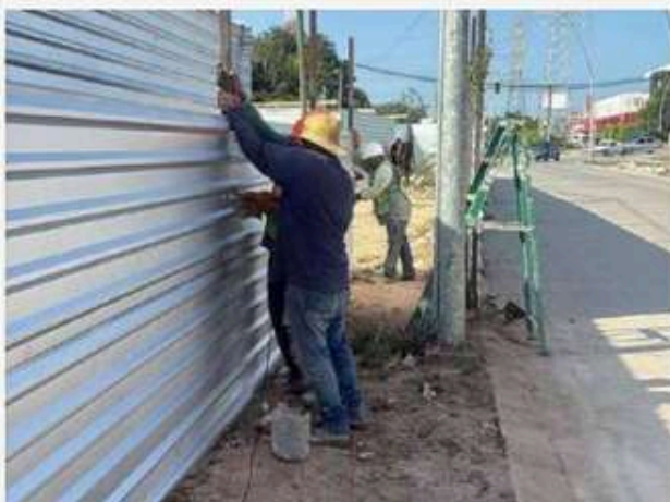
01 • Obras preliminares y confinamiento
