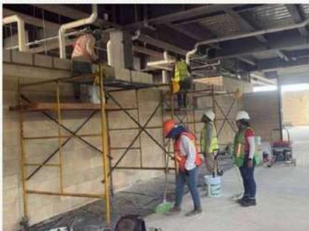
05 • Albañilería y muros divisorios
