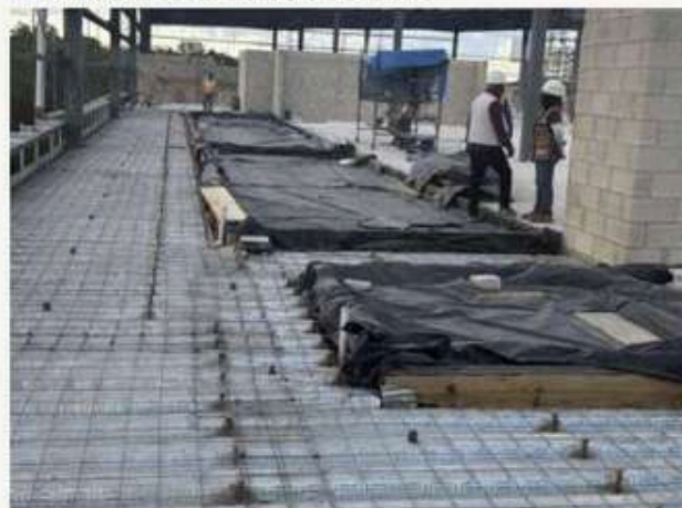
06 • Cimbrado especializado en áreas frigoríficas
